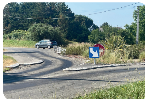
Des travaux à reprendre et terminer rue de l'Ousse
